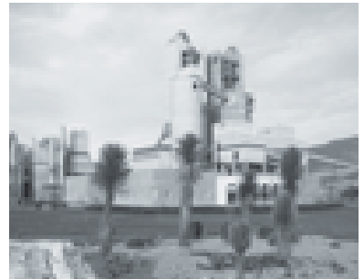
The Cerritos (Mexico) cement plant.
